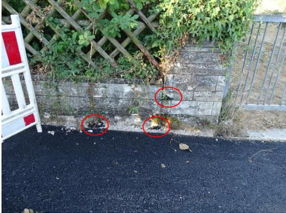
**Abb. 4: Neuer Asphalt auf dem Gehweg nördlich Flst. 545/1 und Verfüllung der Mauerfugen mit Asphalt**
