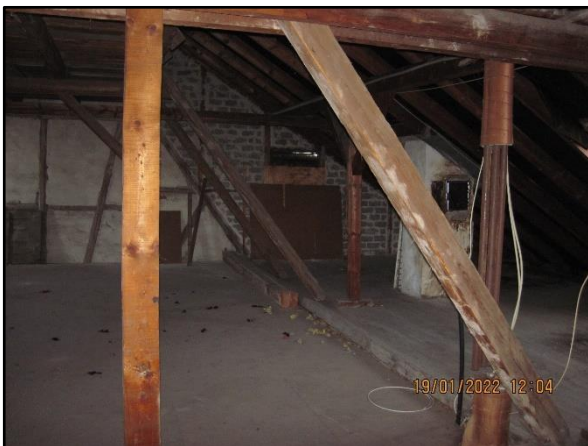
Abb. 19: Dachstuhl des Mehrfamilienhauses
