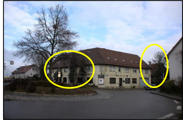
Abb. 6: Vorderansicht der Gaststätte mit auf dem Grundstück befindlichen Bäumen (eingekreist)
