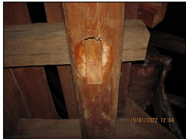
Abb. 14: Balkenkehle im Dachstuhl des Mehrfamilienhauses
