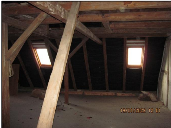
Abb. 21: Dachstuhl des Mehrfamilienhauses
