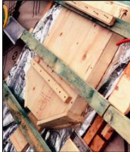
Abb. 34: Integration eines Fledermauskastens unter der Dachhaut 4
